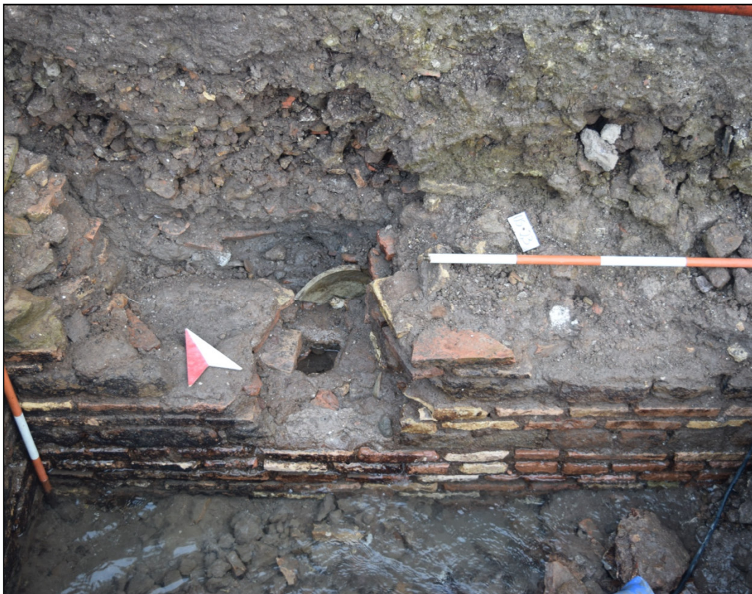
Fig. 4 Panoramica dell'apertura strombata in USM 23.
