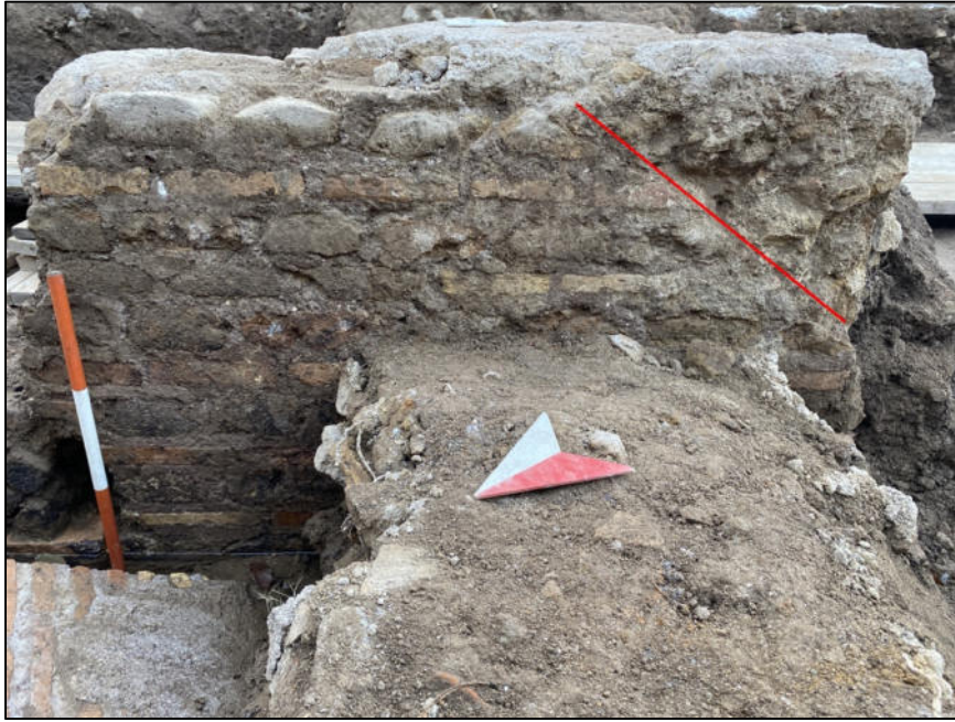
Fig. 8 Il paramento NW del muro in vittato USM 17 con evidenziata la traccia obliqua.
